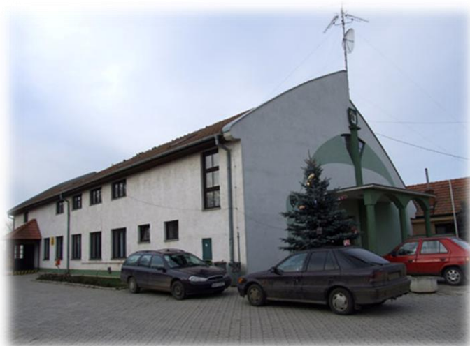
Budova obecného domu
